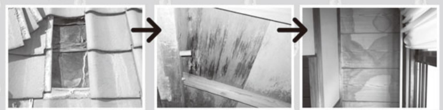
ルーフィングがボロボロ 野地板に染み込んだ雨水 天井の雨染みで気付く
